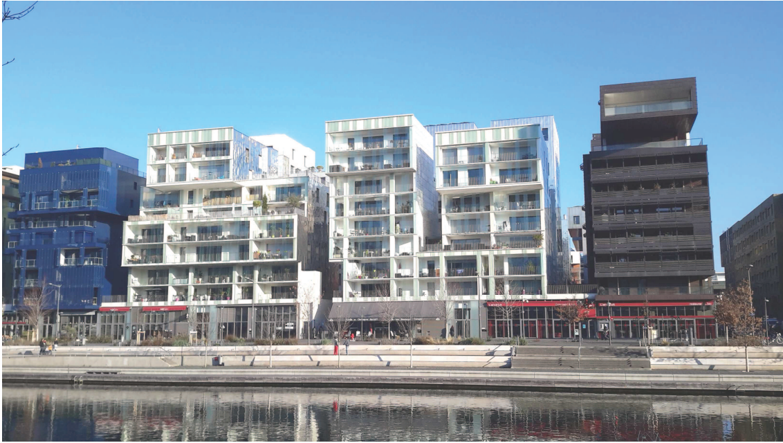
Lyon. Quartiere Confluence. Edifici Ilot B (archivio fotografico ©G. Prestia, 2015).
