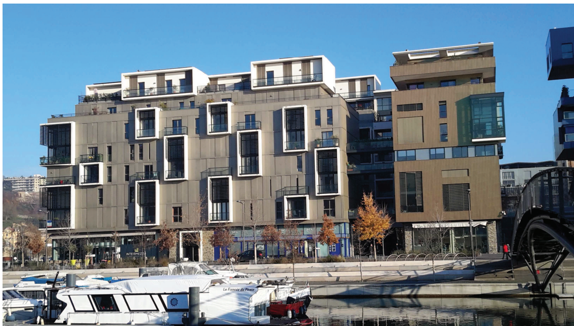
Lyon. Quartiere Confluence. Edifici Ilot A (archivio fotografico ©G. Prestia, 2015).
