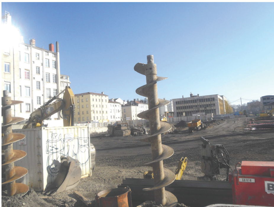
Lyon. Quartiere Confluence. Quai Rambaud, lavori per l'Ilot A3 (archivio fotografico ©G. Prestia, 2015).
