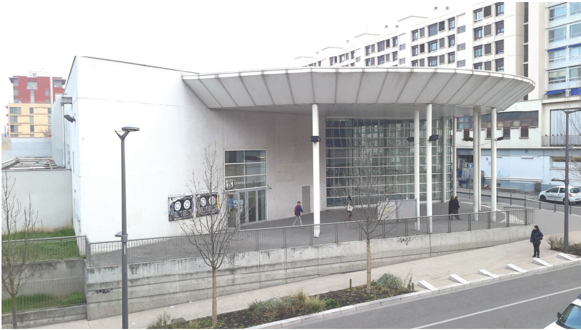
Lyon. Quartiere Confluence. Gymnase Chanfray (archivio fotografico ©G. Prestia, 2015).
