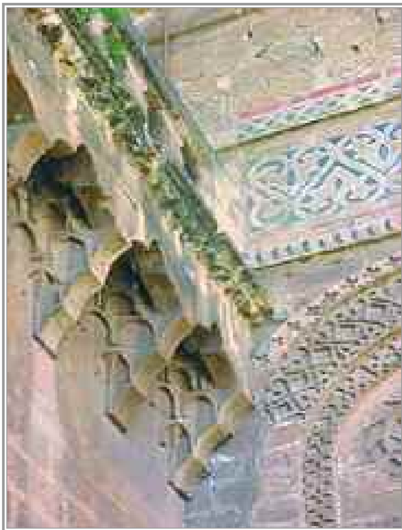
Palermo. Cattedrale. Prospetto orientale della torre scalare sud-occidentale, particolare della decorazione a muqarnas. Fonte: ph. Ruggero Longo
