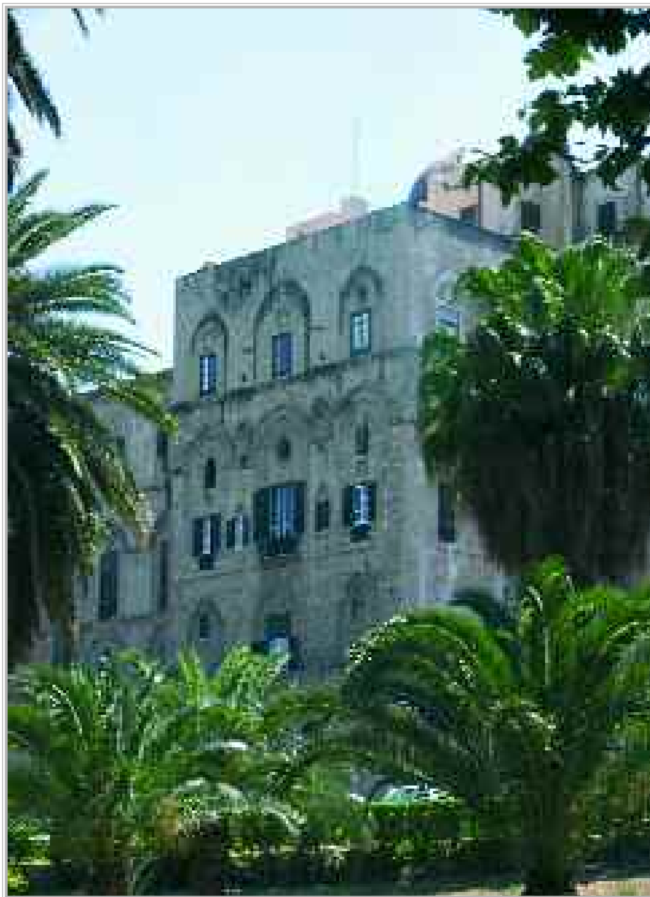
Palermo, Palazzo dei Normanni. Prospetto sud-est. Fonte: da Palazzo dei Normanni 2006
