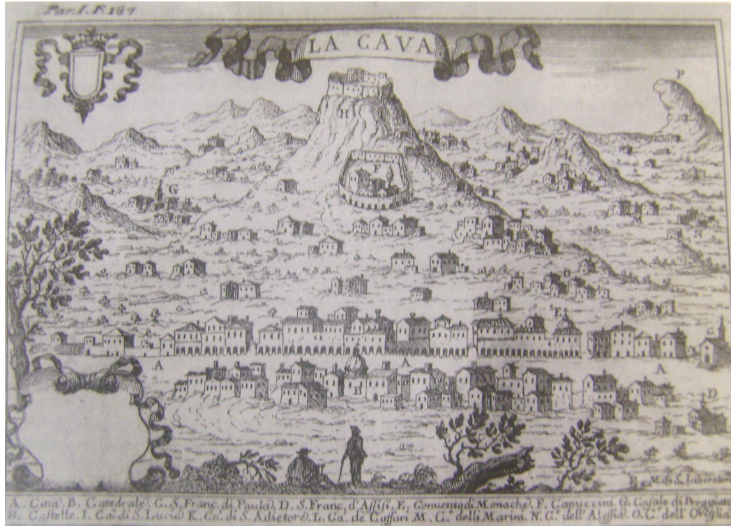
FIG. 5.1 – Il versante orientale di Cava illustrato nel 1703 nel volume del Pacichelli. In primo piano i portici del borgo Scacciaventi (Fonte: Gravagnuolo, 1994)
