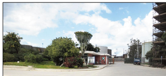
Fig. 5 L'ingresso alla centrale
