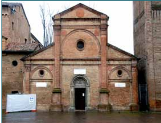
Baldassarre Peruzzi, Facciata della Chiesa della Sagra in Carpi, 1515.
