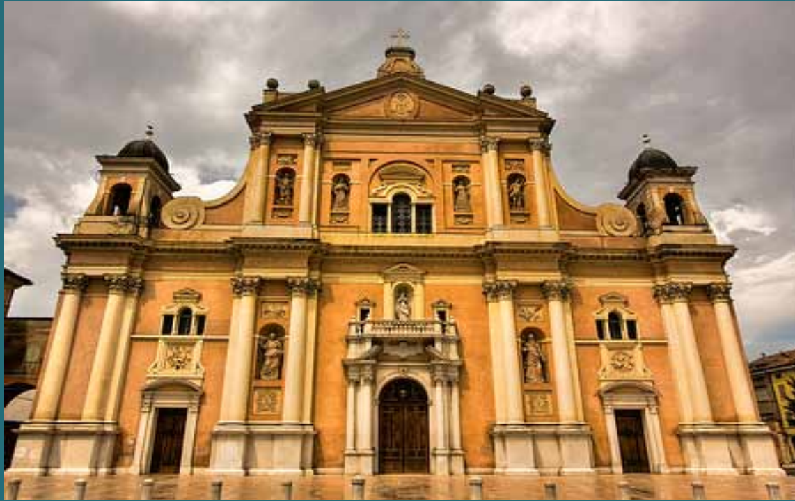
Facciata del Duomo di Carpi
